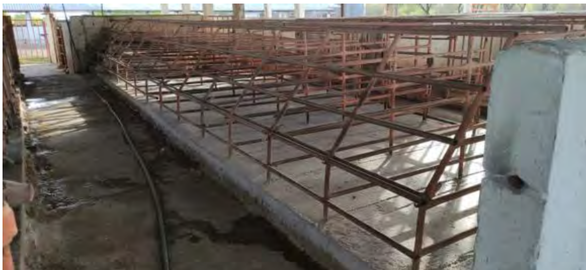
Mantenimiento del piso en el área de gestación.
