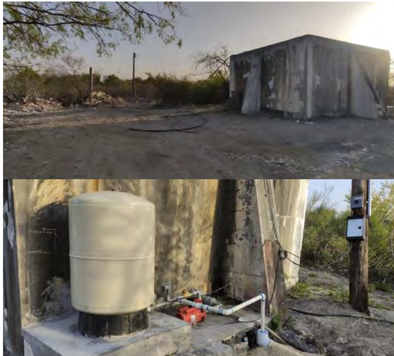
Acondicionamiento de pozo y pila.
