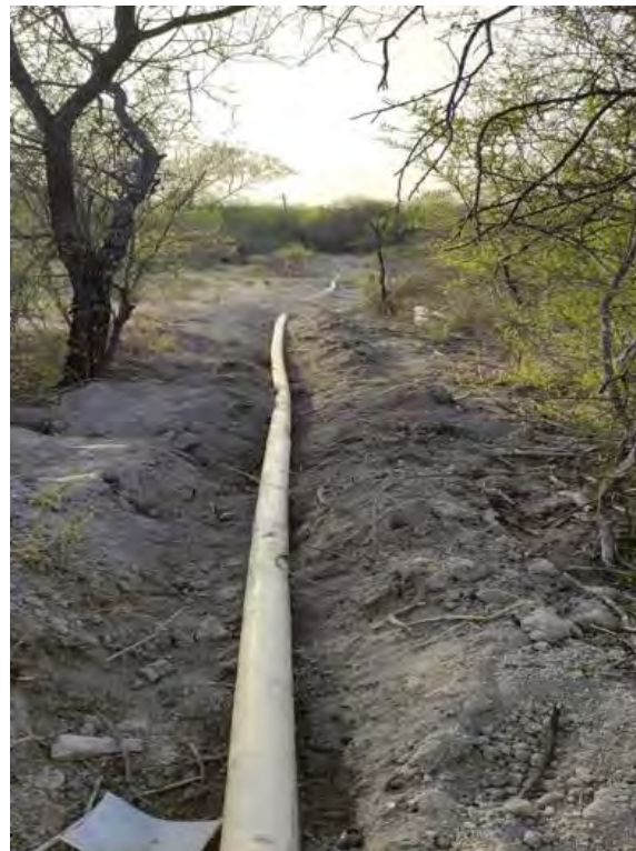
Instalación de tubería de PVC reciclado de 4”.
