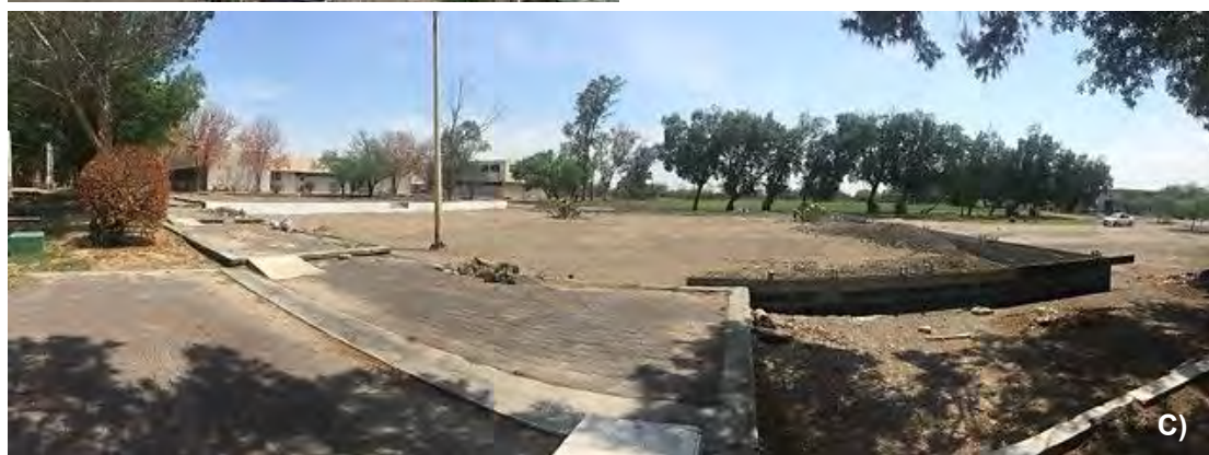
Área 2 del Jardín Etnobiológico Sede FA-Marín. A) Ubicación. B) Muestra de plantas bajo estatus de protección ambiental que serán resguardadas en el jardín. C) Avances en la delimitación, relleno y nivelación del área 2.
