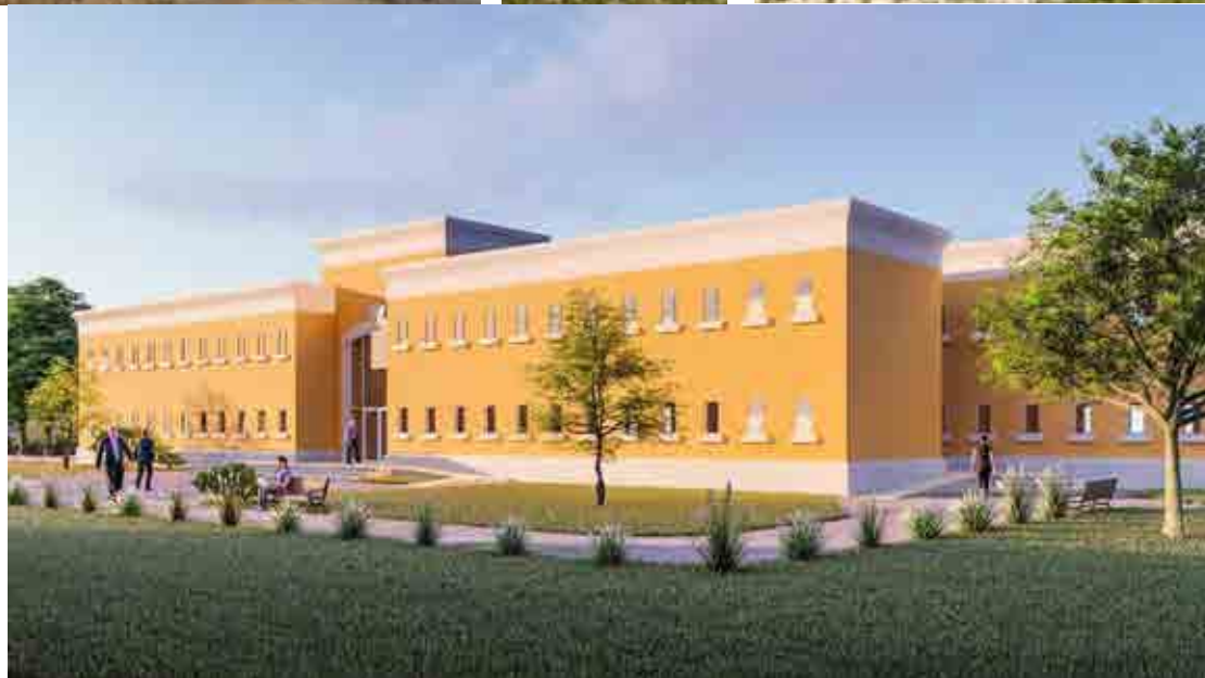
Imagen 47. Avances y proyección de la construcción de dormitorios en la Unidad Académica La Ascensión.
